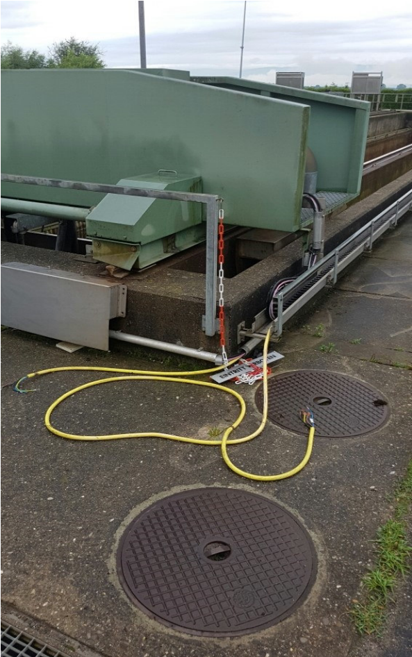
Kabel NKB-Räumer ersetzt.
