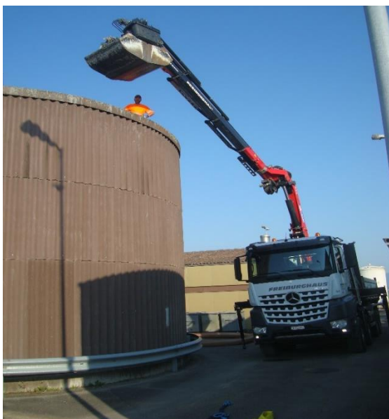
Reinigung Faulturm 1 mit Freiburghaus
