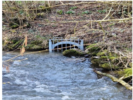
Gitter gegen Biber montiert
